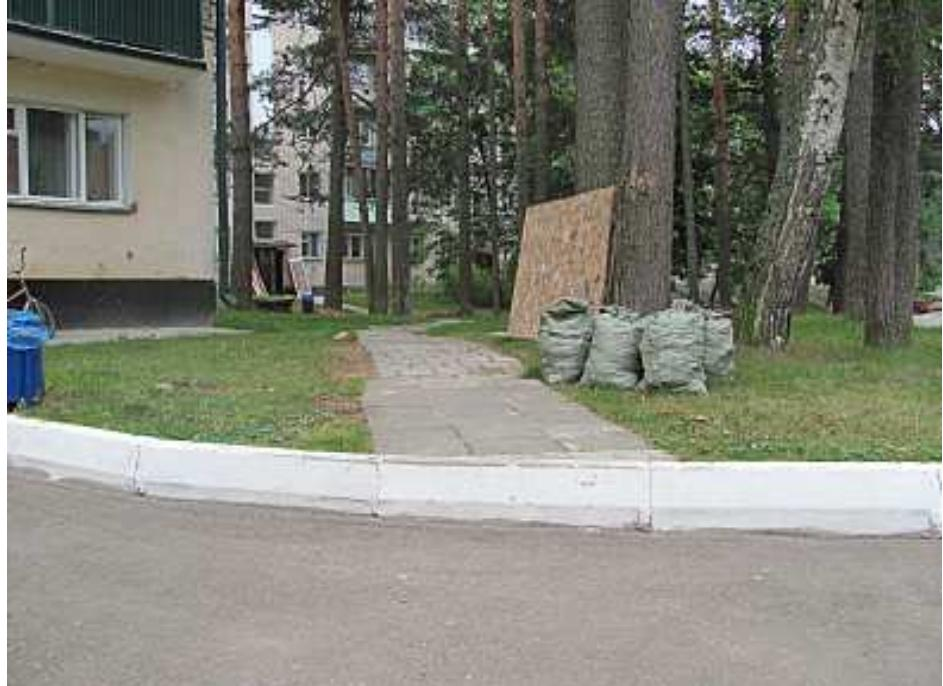
И ещё цитата из СНиПа: «В местах пересечения ... пешеходных дорожек с тротуарами, проезжей частью улиц БОРТОВЫЕ КАМНИ ДОЛЖНЫ ЗАГЛУБЛЯТЬСЯ с устройством ПЛАВНЫХ ПРИМЫКАНИЙ для обеспечения проезда детских колясок, санок и т.д.»
